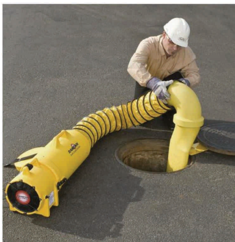
Esempio di impianto di ventilazione per accesso e lavori in ambienti confinati o sospetti di inquinamento
