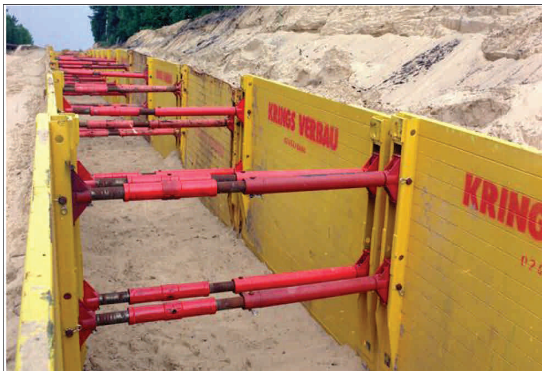
Blindo TIPO 1 – foto esempio sistema compatto rinforzato ai bordi
