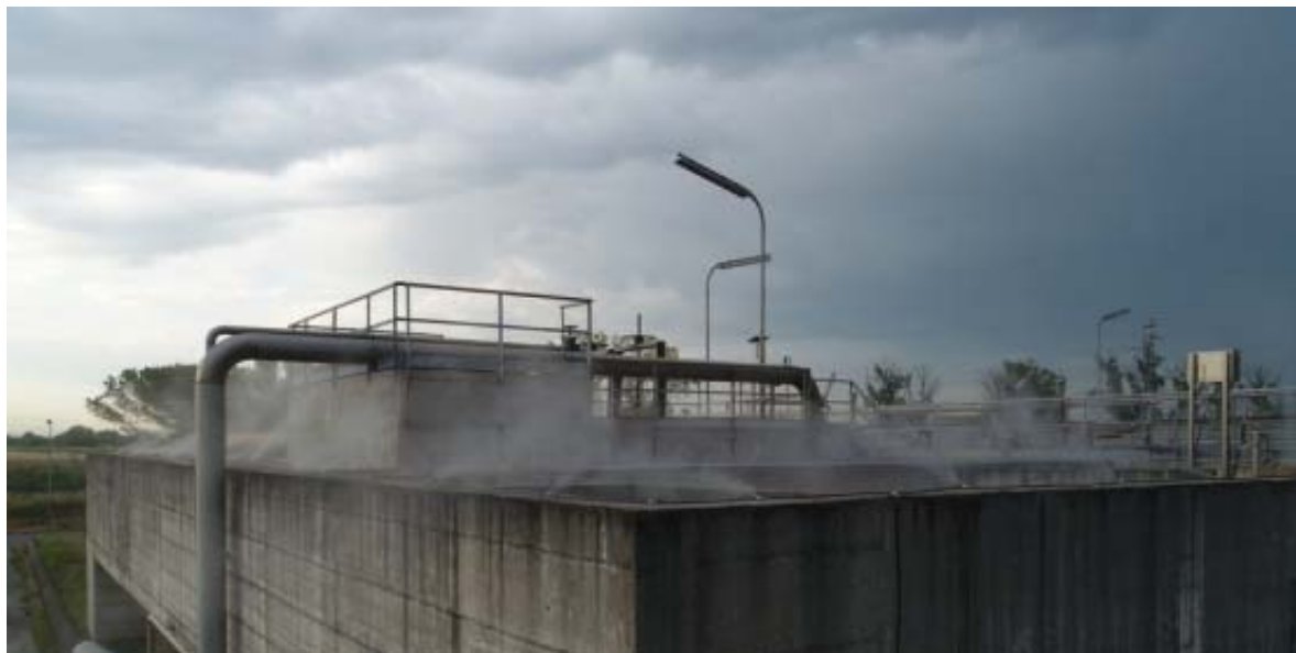
I nebulizzatori del depuratore del Calice
