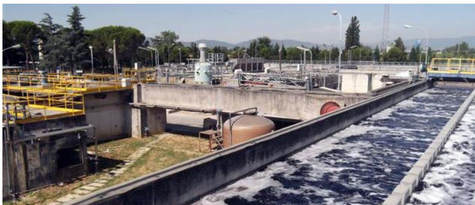
La linea fanghi è composta da ispessimento a gravità e disidratazione meccanica con centrifuga.
